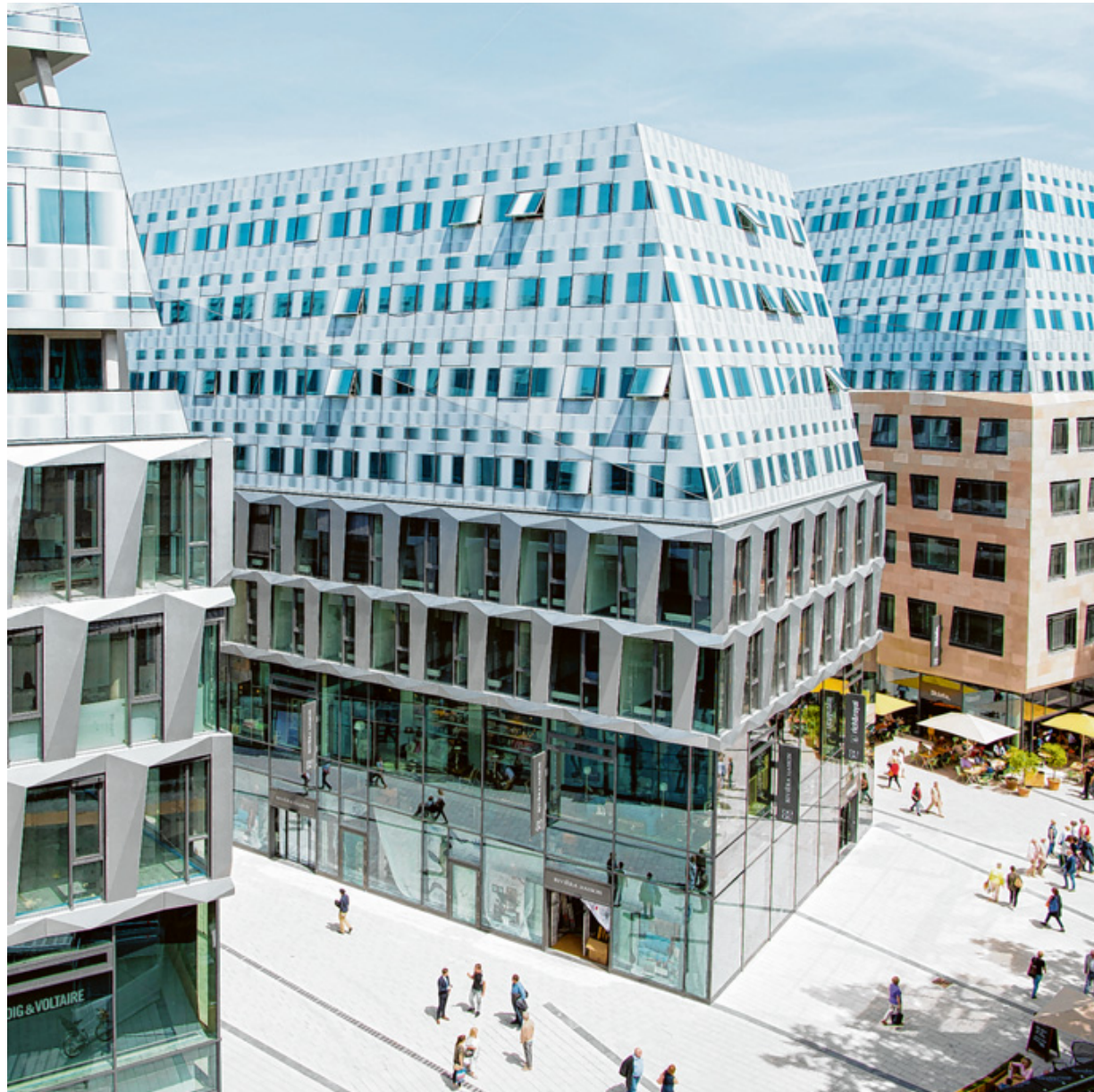
Ein Hauch von Elbphilharmonie? Futuristisch mutet die Fassade des Dorotheen-Quartiers in Stuttgart an. Die komplette Außenverkleidung stammt von der Gersthofer Stahl- und Glasbaufirma Roschmann. Foto: David Matthiessen
